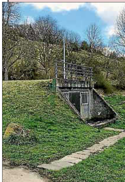
An dieser Stelle ist eine neue Druckerhöhungsanlage anstatt des Wasserturms geplant
