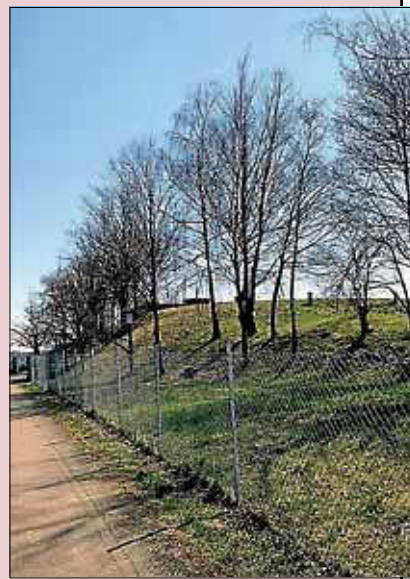
Der Hochbehälter Seiten versorgt fast 9000 Menschen mit Wasser
