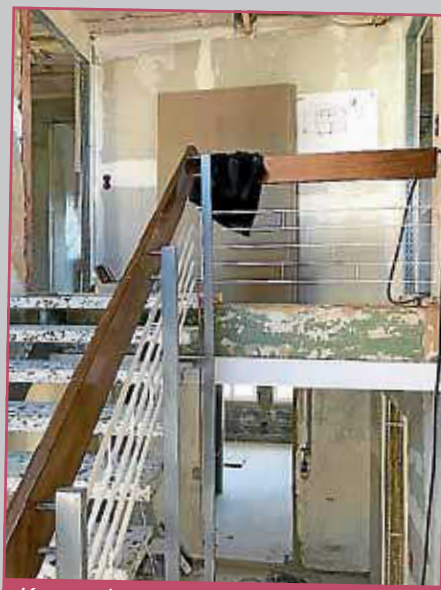
Kaum wiederzuerkennen ist die Einteilung – doch der Treppenaufgang bleibt
